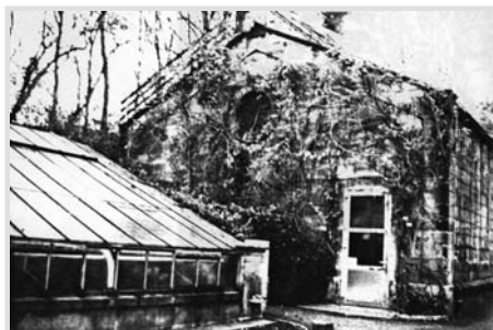
Ansicht Westgiebel - Bewuchs Zustand bis 1995
