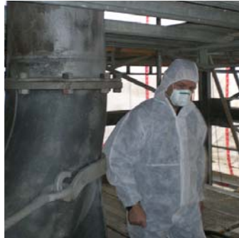
Fotos: Fa. Saal Korrosionsschutz
