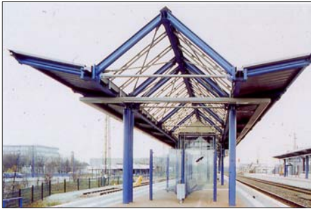
Vordach Bahnhof - Dormagen
